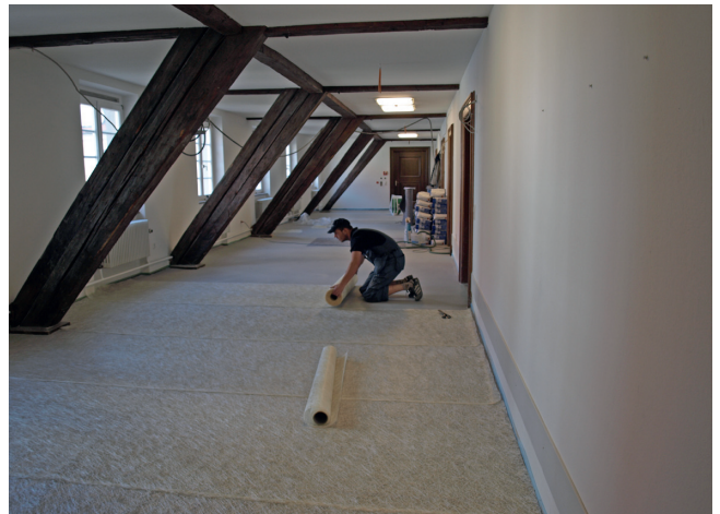
Flächiges Auslegen von UZIN RR 201 auf den zu sanierenden Untergrund.
